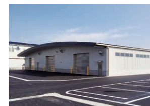
ストックヤード棟
