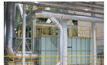
施設内の各所で集められた粉じんをバグフィルタで除去し、活性炭を充填した脱臭装置により臭気を除去します。
