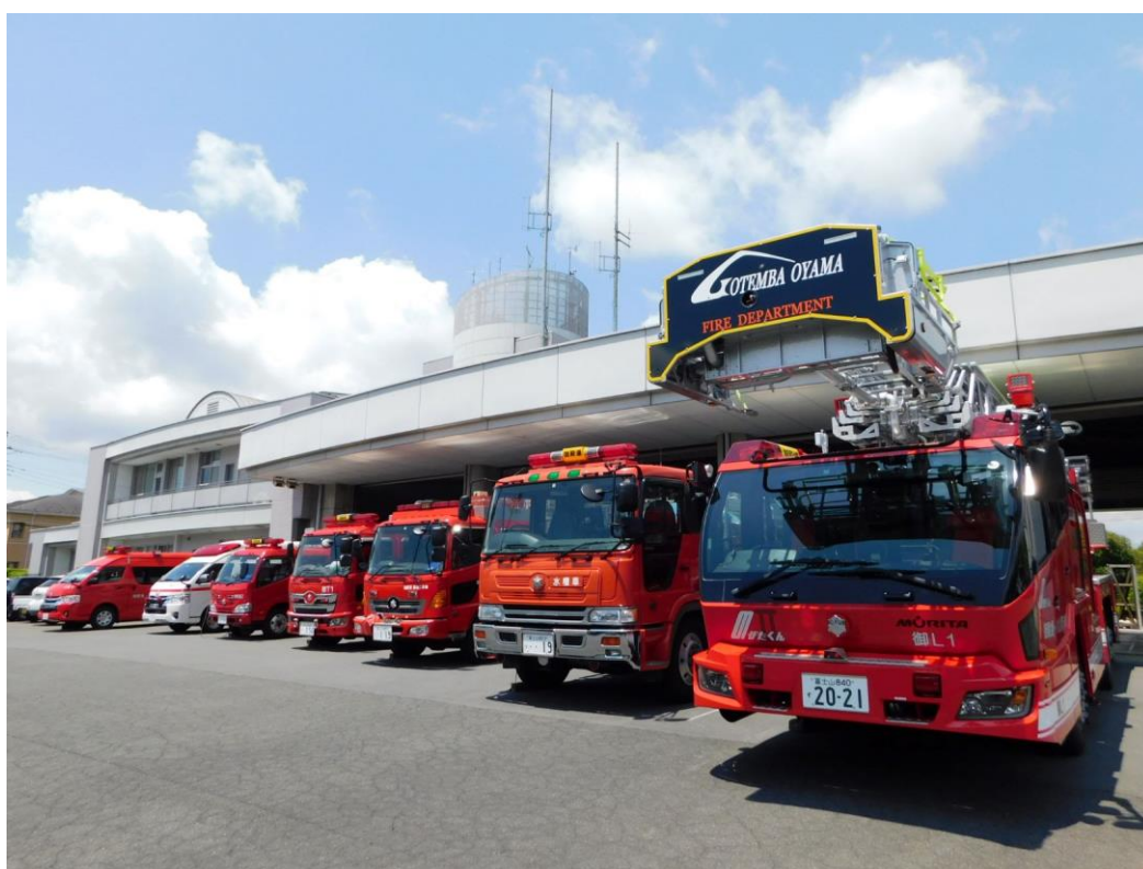
(御殿場市・小山町広域行政組合消防本部庁舎及び車両)
